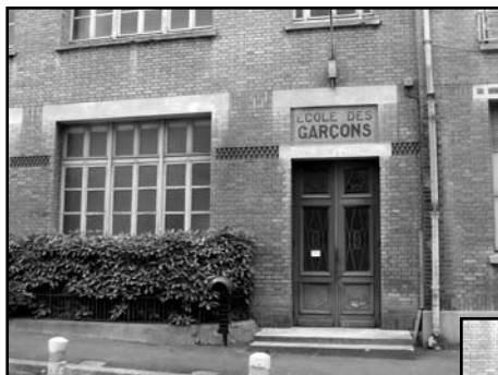
Des entrées séparées !
